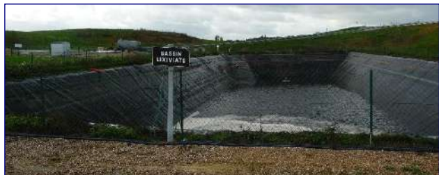
Photo 5 : Clôture d'un bassin de stockage des lixiviats
