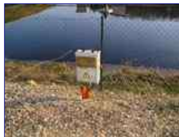
Photo 2 : Coupure pompe au niveau du bassin lixiviat
