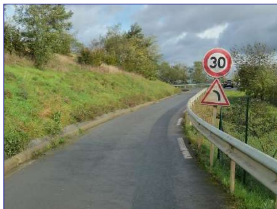
Photo 3 : Exemple de panneau de signalisation présent sur le site
