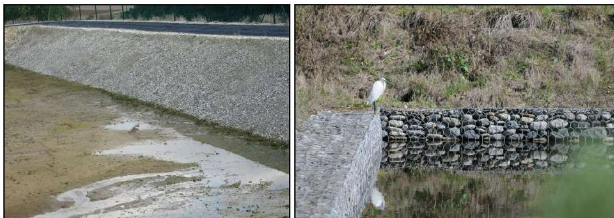
Figure 33 : Exemple de traitement de talus de bassins pentes fortes ou gabions
