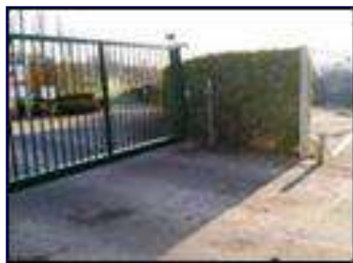
Photo 7 : Portail du site fermé en dehors des heures d'ouverture
