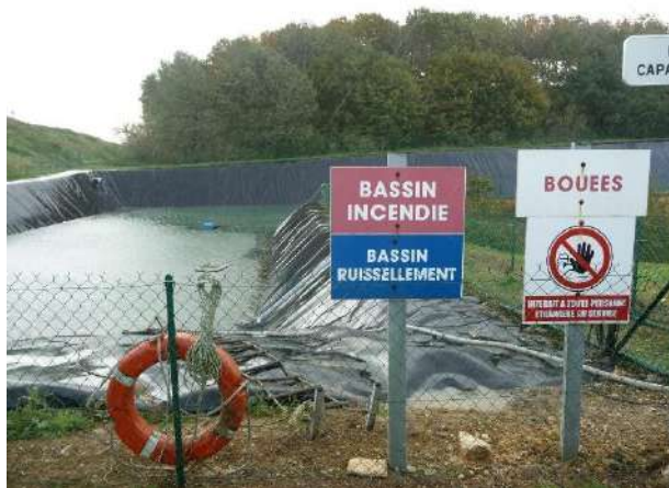
Photo 6 : Moyens de secours disponibles à proximité immédiate des bassins
